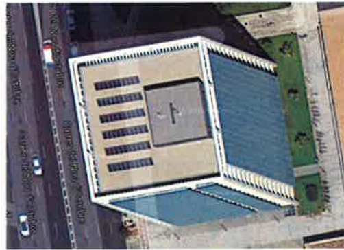
Vista de la cubierta Torre I
