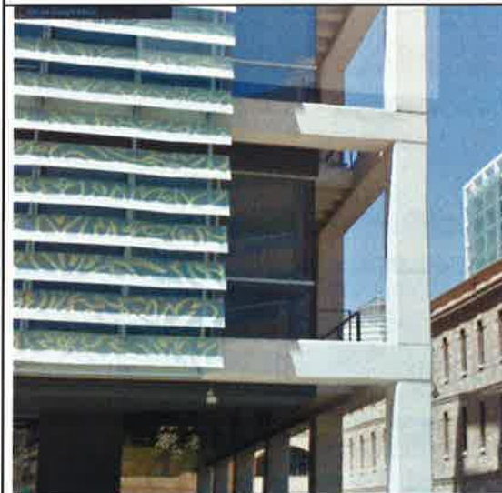
Detalle de sistema de fachada: muro cortina y sombreado con lamas de vidrio
